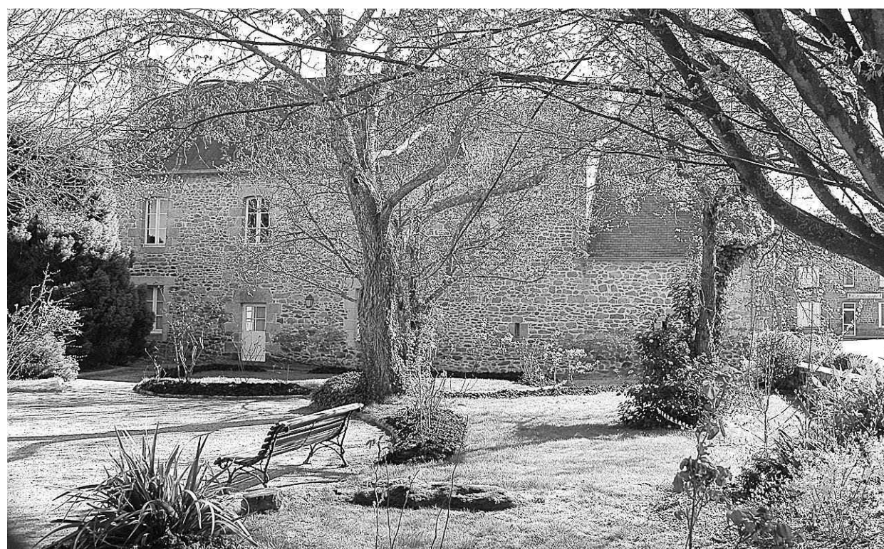
La future bibliothèque occupera l'ancien presbytère déjà en partie bibliothèque et un nouvel espace qui va être construit à l'arrière du bâtiment jusqu'au terrain de boules où se trouve l'ancien moulin à pommes (notre photo).
